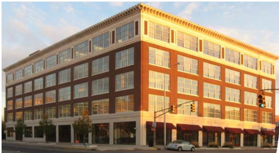
Upravení perspektivy tak, že obě strany budovy jsou shodně zkráceny
